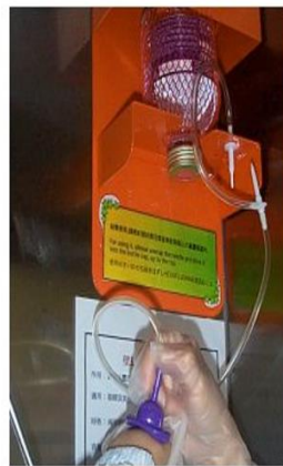
圖四 鐵氟龍接頭插入、眼杯 沖洗面部
